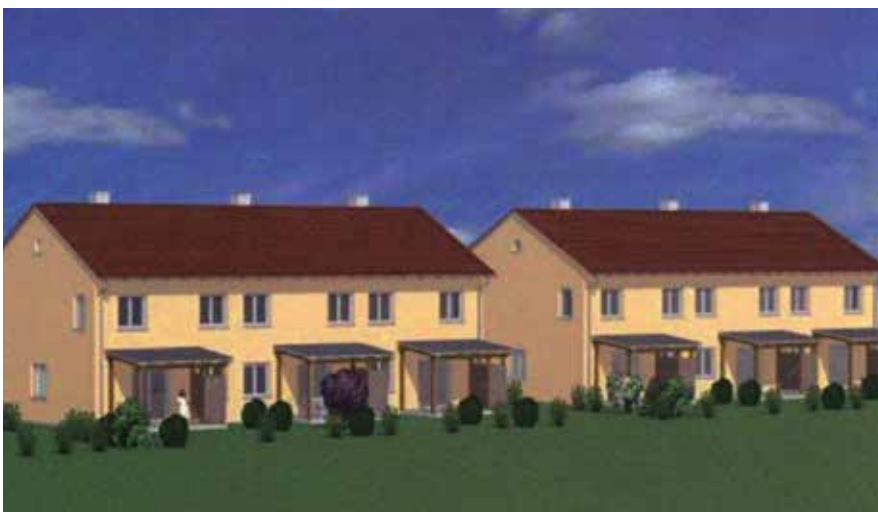
Im Oktober 2015 wird mit der Errichtung von zwei weiteren Objekten in der Münzgrabensiedlung durch die ENW Wohnbaugesellschaft begonnen.
