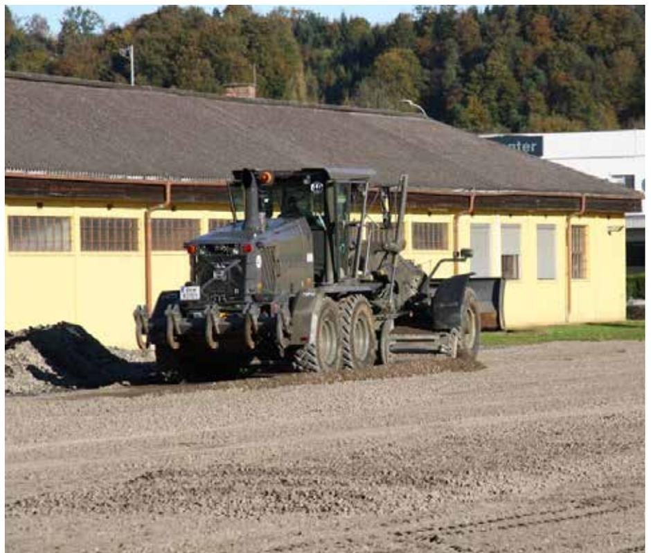
*Der erste Schritt zum neuen Unterkunftcontainer-Complexes waren die Planierungsarbeiten mit dem eigens dafür antransportierten Pioniergerät.*
