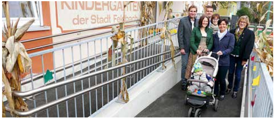
Kindergarten Sonnenschein durch neue Rampe barrierefrei
