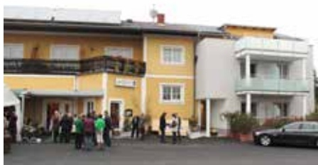
Gelungene Anbindung des Zubaus zum Altbestand
