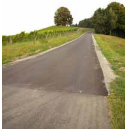
Neue Asphaltdecke für die Rosenbergstraße
