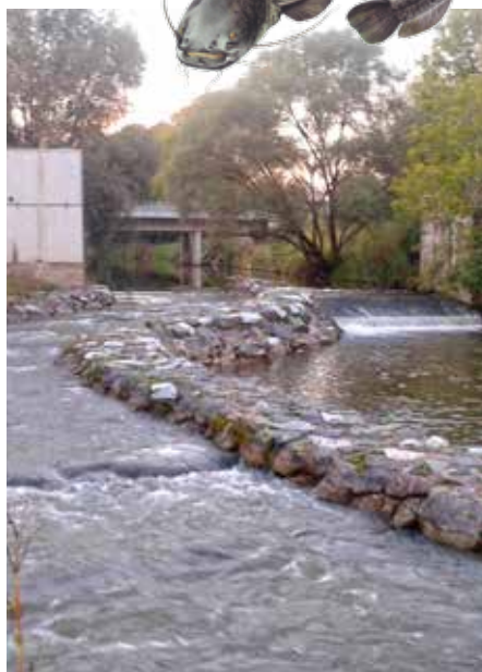
Schlitzpass bei der Clement-Wehr (Feldbach), eigener Wasserlauf im Flussbett bei der Ertler-Mühle (Raabau)
