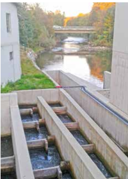
Schlitzpass bei der Clement-Wehr (Feldbach), eigener Wasserlauf im Flussbett bei der Ertler-Mühle (Raabau)
