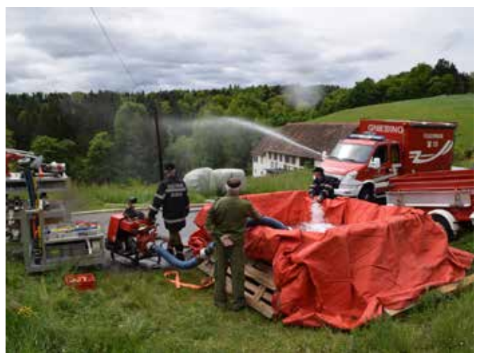
Mit Paletten und Steckleitern wurden Löschbehälter aufgebaut, um genügend Wasser zur Verfügung zu haben.
