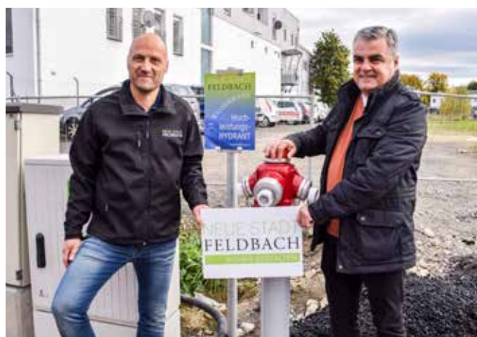
Leiter-Stv. Gottfried Schanner vom Städtischen Wasserwerk und Sicherheitsbeauftragter GR Josef Gsöls beim neuen Hochleistungshydranten in der Lugitschstraße.
