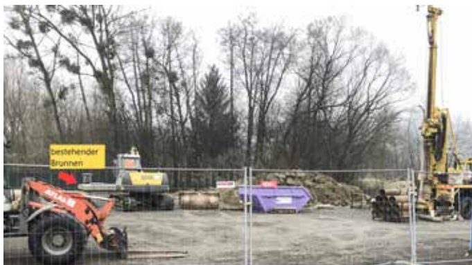
Probepbohrungen beim Freizeitzentrum Feldbach
