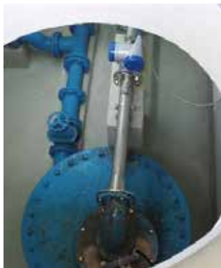
Brunnen mit Zählanlage
