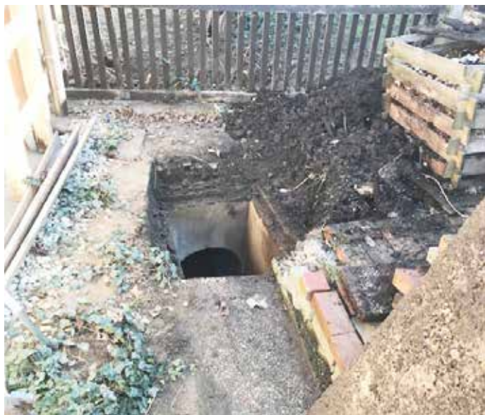
Viele Schachtabdeckungen mussten erst freigelegt werden.
