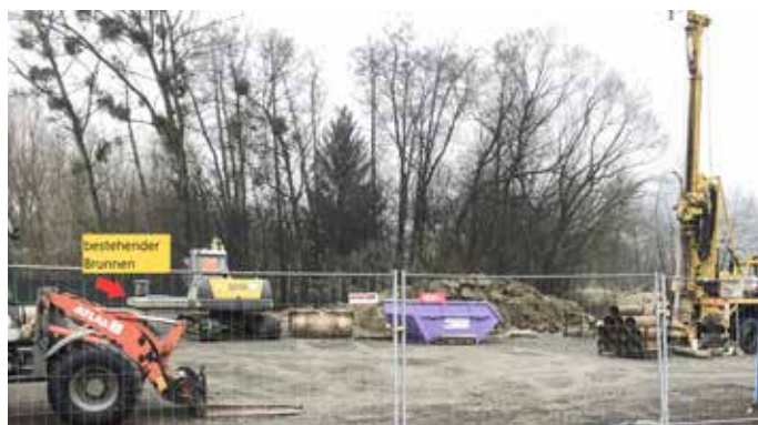
Probepbohrungen beim Freizeitzentrum Feldbach
